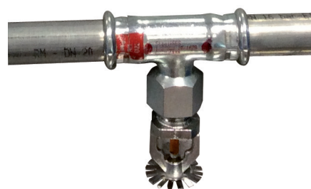
Fig. 19 - Instalación de splinkers contra incendios vía húmeda.
