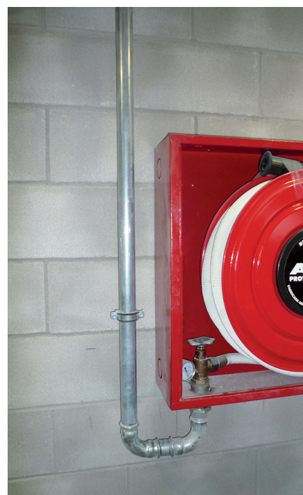
Fig. 17 - 18 Instalación de BIE's contra incendios.
