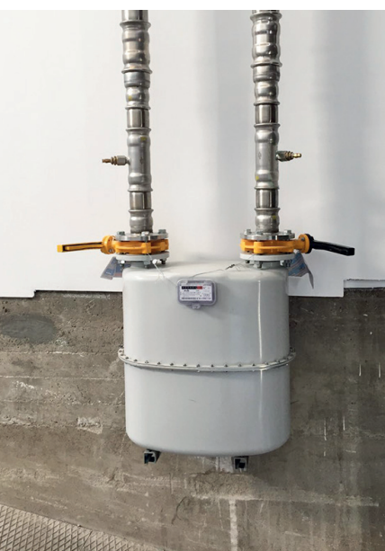
Fig. 21 - Instalación gas en nave industrial
